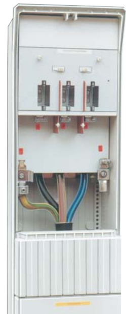
nach dem Anschließen des Abgangskabels Konsumenten- raum abdecken
