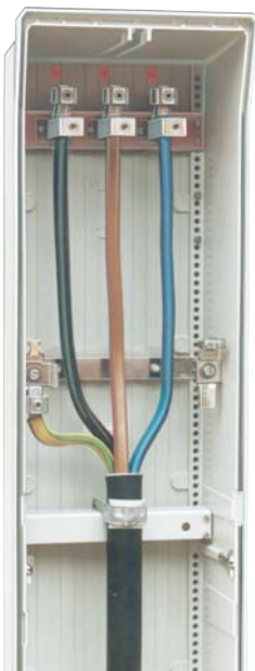
Leiter ablängen, einlegen, befestigen
