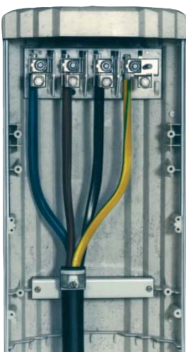
Leiter ablängen, einlegen, befestigen
