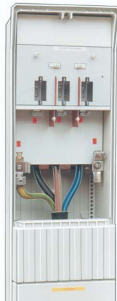
Berührungsschutzabdeckung über dem Zugangsteil befestigen, plombieren
